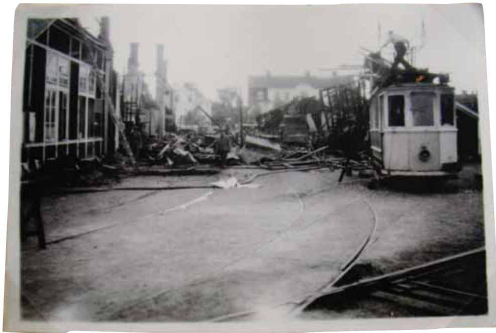
Spårvagnshallarna på Dalgatan vid Norra Station efter branden år 1945. Enhagen i bakgrunden. Idag ligger här äldreboendet Ramund. FOTO Frisks Foto
