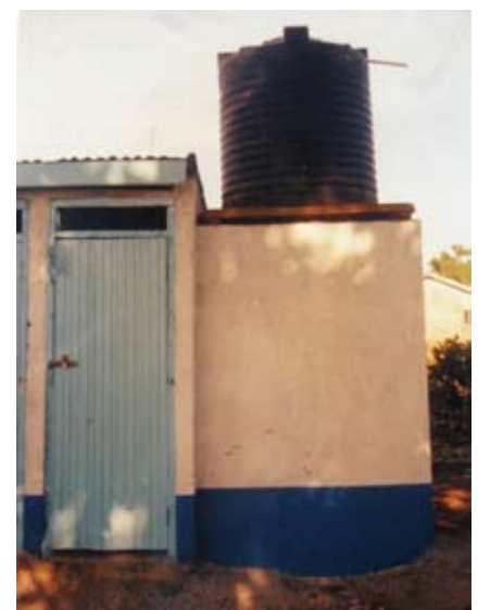
Ny vattentank: Den gamla rostiga tanken med hål i är ersatt av en ny i plast som både rymmer mer och håller vattnet fräschare.
